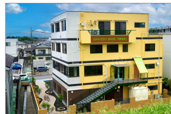
リノベーション後の姿。羽根倉通りの入口から2階「KURU」への階段に至ります。
